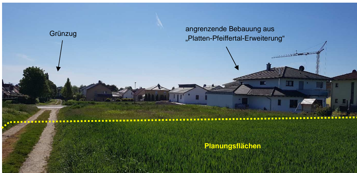
Blick von der geplanten Pkw-Wende/Flurweg auf den bestehenden Flurweg mit Grünzug in Richtung Ortskern/Osten
