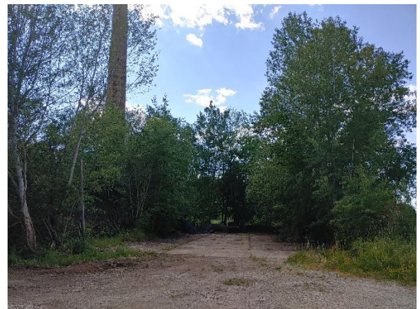
Abbildung 12: Betonierter Lagerplatz neben dem Ziegeleiturm
