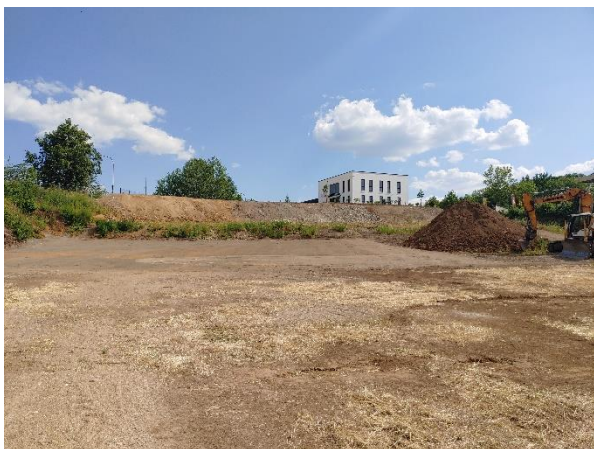
Abbildung 13: Blick Richtung Südosten auf neues Bürogebäude
